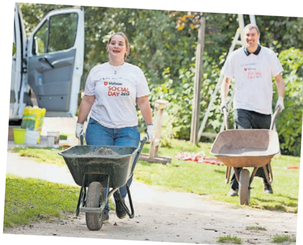
Von Aussenspielfeld bis Zaun: Das Gelände der Kita Johann-Sebastian-Bach-Straße wurde rundum erneuert.
